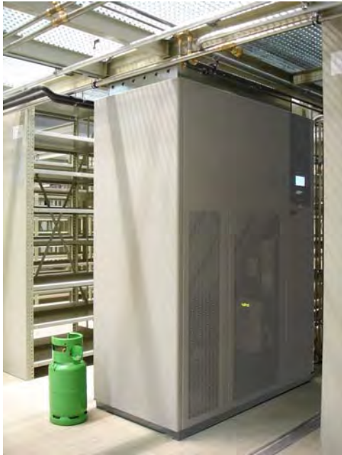
Präzisionsklimagerät
